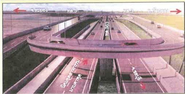
รูปที่ 3 (ทางแยกเนินสำคัญเมื่อก่อสร้างแล้วเสร็จ)
