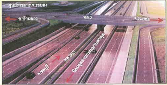
รูปที่ 2 (ทางแยกเนินสำคัญเมื่อก่อสร้างแล้วเสร็จ)
