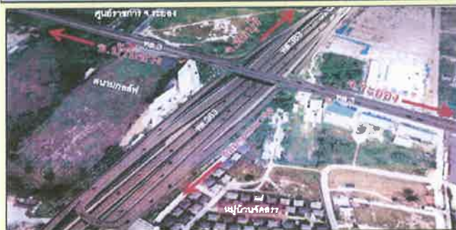
รูปที่ 1 (ทางแยกดินสำลีด้อยก่อสร้างแล้วเสร็จ)
