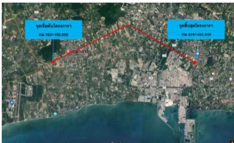
โครงการก่อสร้างทางหลวงหมายเลข 3 สาย อ.บ้านฉาง – ระยอง ตอน 2
